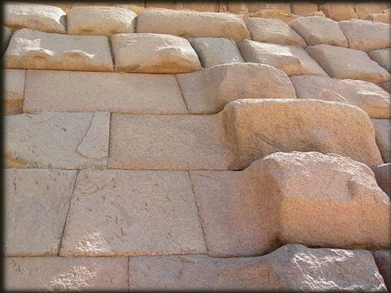
Храм Хатшепсут. Профилированная деталь фасада. Хорошее качество обработки деталей, выборка паза могла быть осуществлена вращающимся медным диском с добавлением корундового порошка и подачей воды
